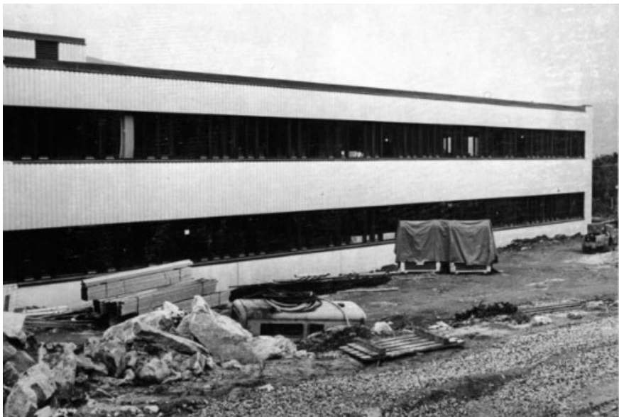
Gjennomgangsbygget under oppføring i 1974. (Foto: UiT)
