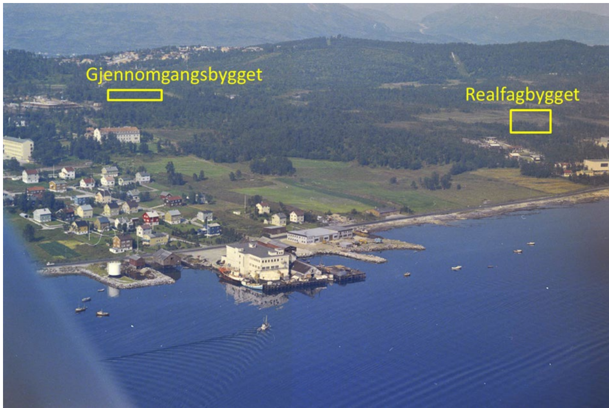
Breivika i 1969 før utbyggingen av universitetet. Oppe til venstre kan sees Grønnåsen skole som er under oppføring. Arbeidene med Gjennomgangsbygget er enda ikke startet, men kom like til høyre for skolen i 1974. Yrkesskolen (i dag Ishavsbyen videregående skole) kan sees helt til høyre i bildet. (Foto: Fjellanger Widerøe/Perspektivet museum).
