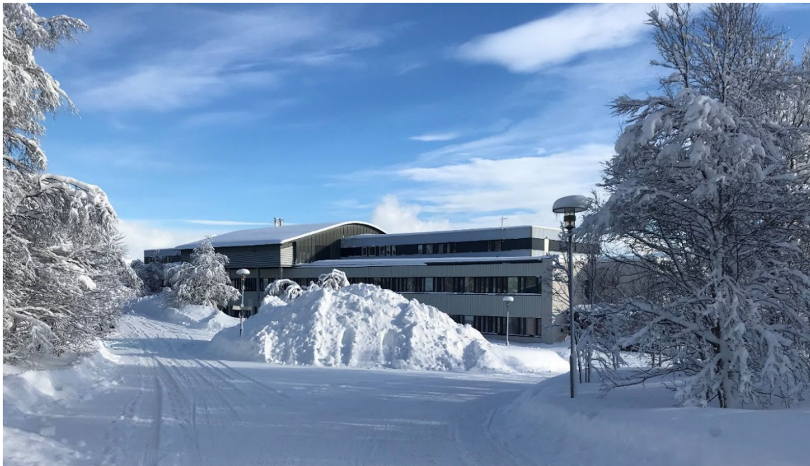
Naturfagbygget har vært igjennom en rekke renoveringer, den siste ferdigstilt i 2022. (Foto: Morten Hald).
