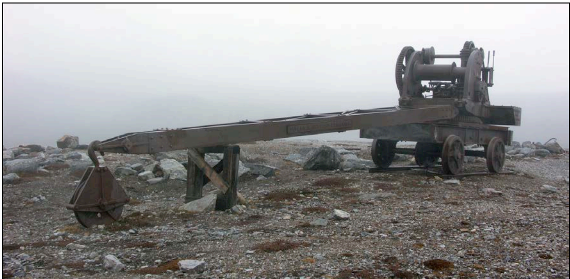
Gammal lyftkran vid ett nedlagd marmorbrott på Blomstrandhalvøya, Svalbard. Det brittiska företaget Northern Exploration Company började brytning här 1911 men den blev aldrig lönsam.
