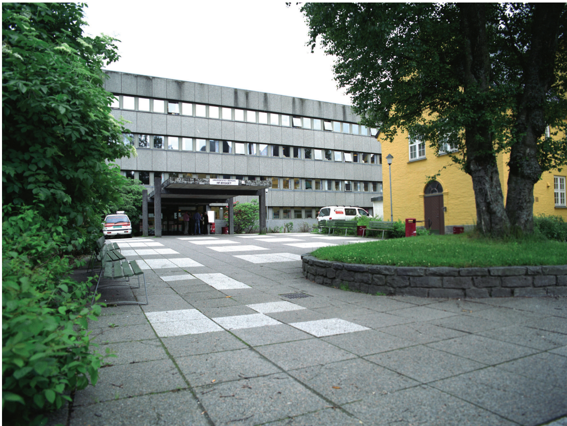
Ill. 5. HF-bygget. Foto: Magnus Vabø 2008.
