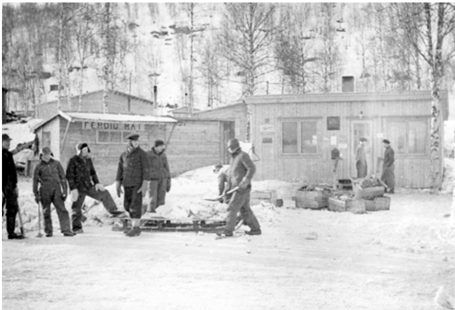
Norske bygningsarbeidarar ved Bardufoss flyplass i 1942. I bakgrunnen eit provisorisk postkontor og kolonialforretning.
