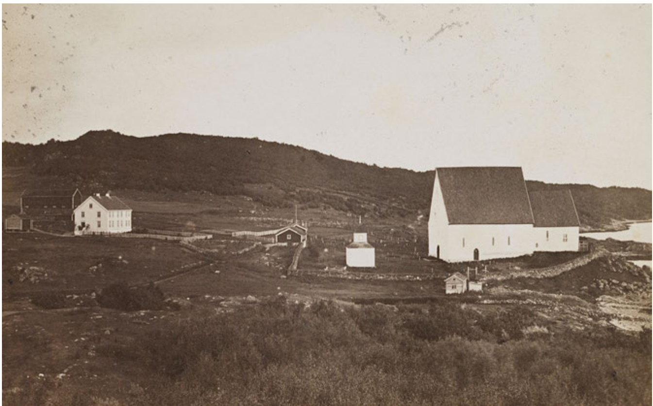
Figur 5. Trondenes kyrkje og prestegard – med litt mindre vegetasjon enn i dag. Foto: Universitetsbiblioteket i Bergen
