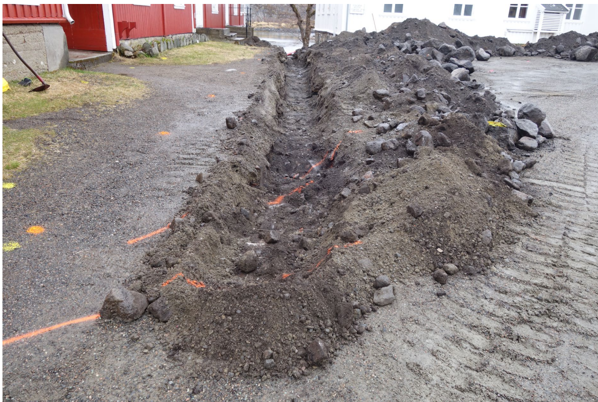
Figur 8 Etter kabelpåvisning – kabler i bakken merket med markeringsspray. Merk forekomsten av større stein fra gårdsplassen like under pukk og grus
