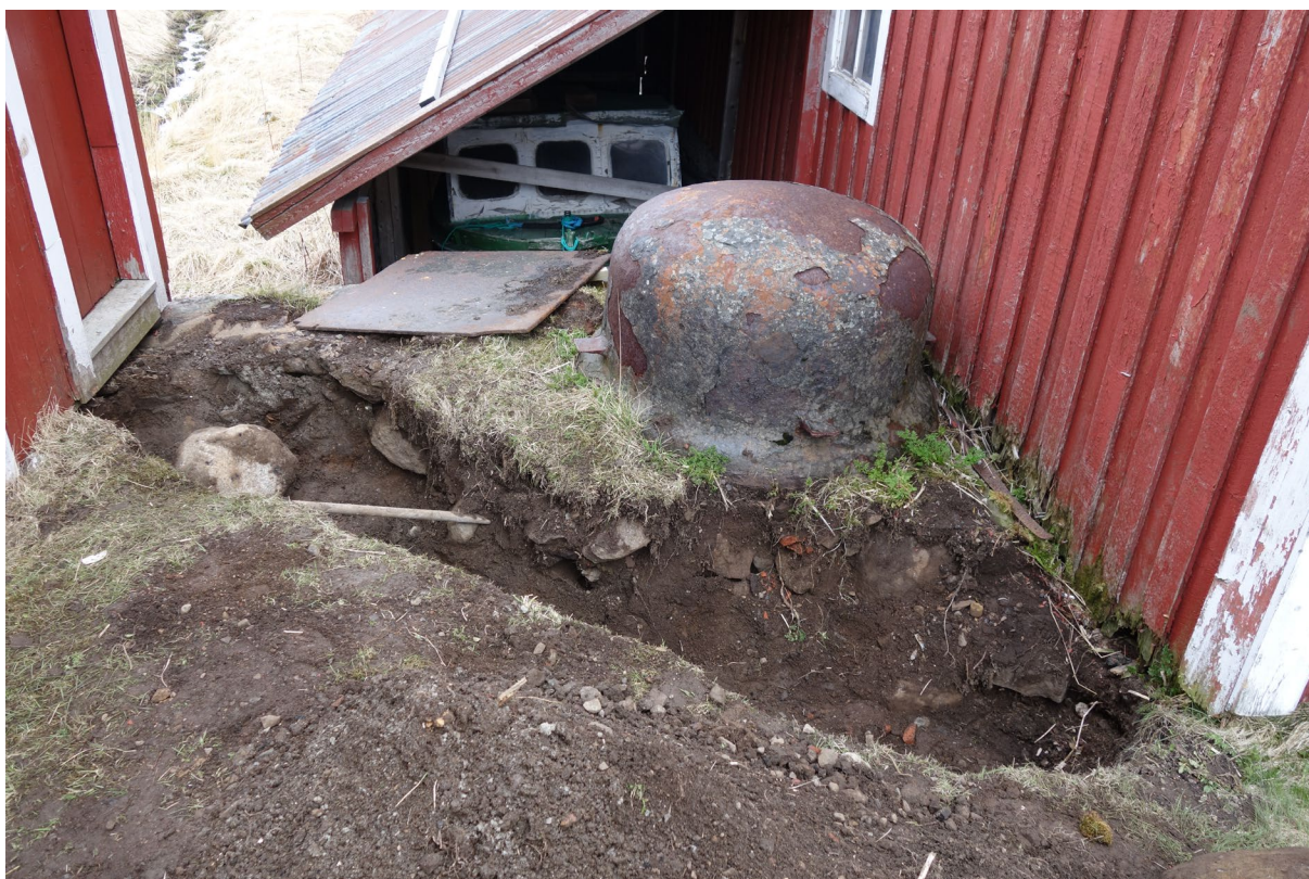
Figur 12 Grøft 4, støttemur i bakgrunn
