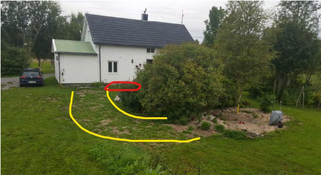
Figur 10 - Trase for ny vannledning (gult) og markering av hvor den forstyrte grava under våningshuset (rødt). Bilde fra Hauglid 2020b.
