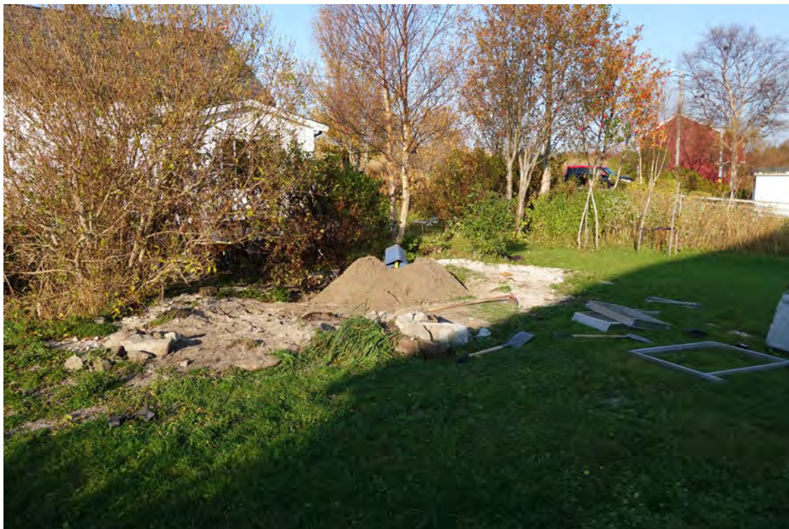
Figur 6 - Grøftmassene ferdigsåldet og deponert i gjenstående grøft
