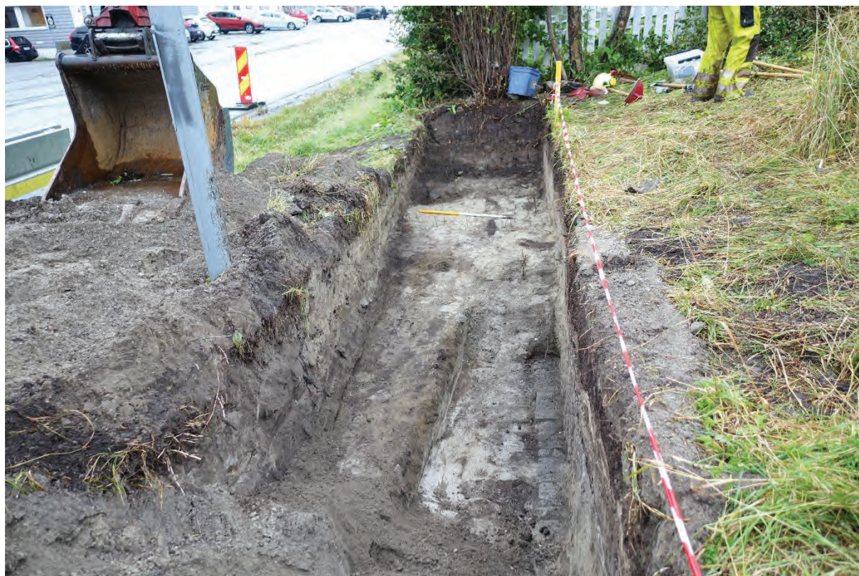
Figur 7 Bilde av den nordvestre enden av sjakta, og de sterkt omrotete massene. Kabeltraseens betongdekke nært kamera
