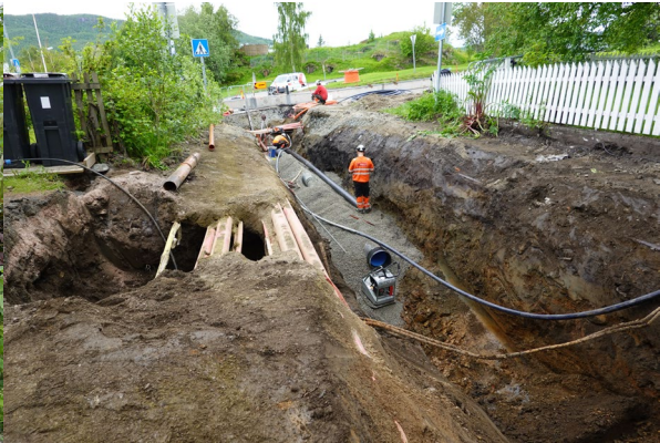
Figur 9 Oversiktsbilde mot sørøst. Inngang til Erikstad gate 1 under kablerør. Gammelt bekkeleie?
