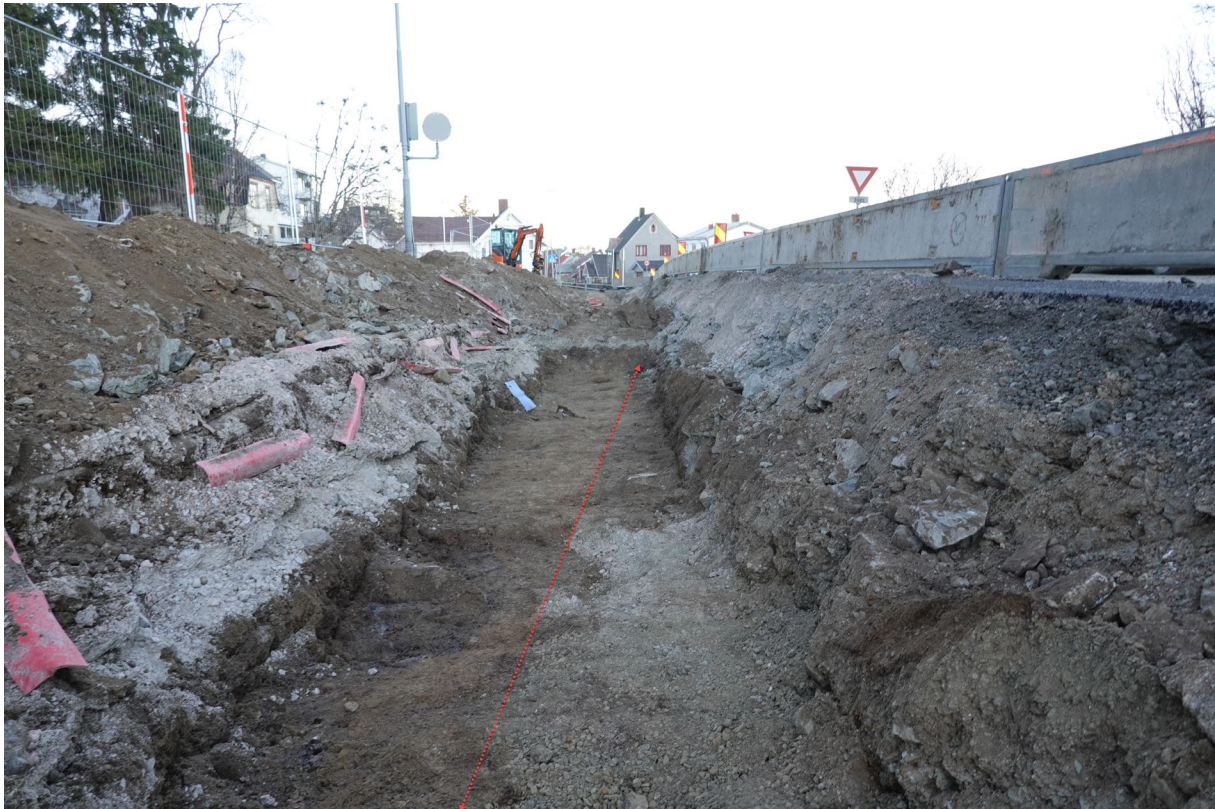
Figur 5 Vannledning (?) under voll, orientert vest-sørvest-øst-nordøst, Bildet tatt fra en kum denne grøften er koblet til
