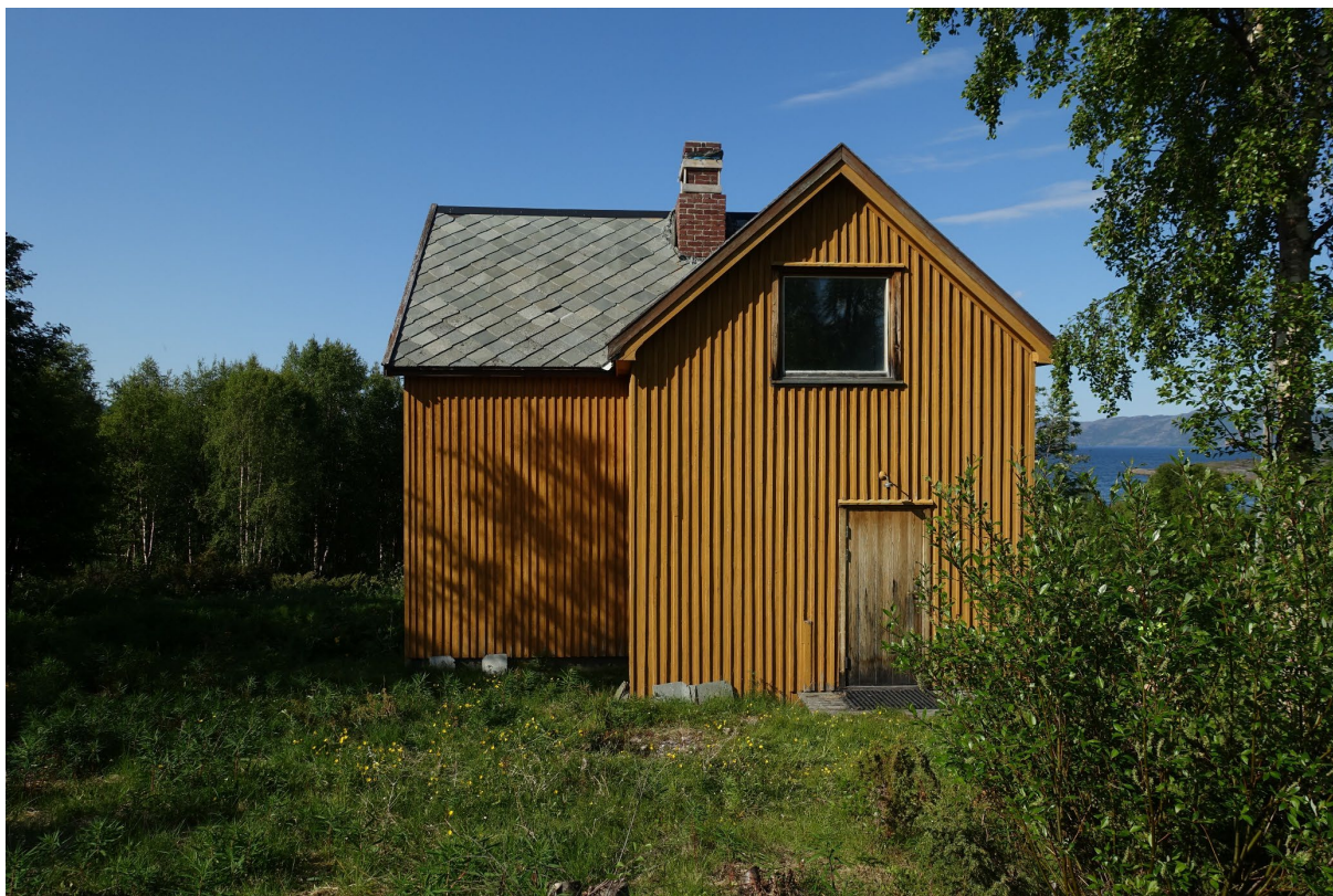
Figur 1 Nilsenhuset sett fra syd før utgravning. Nedenfor husveggene ses nedraste takplater. I bakgrunnen Hjemmeluftbukta.
