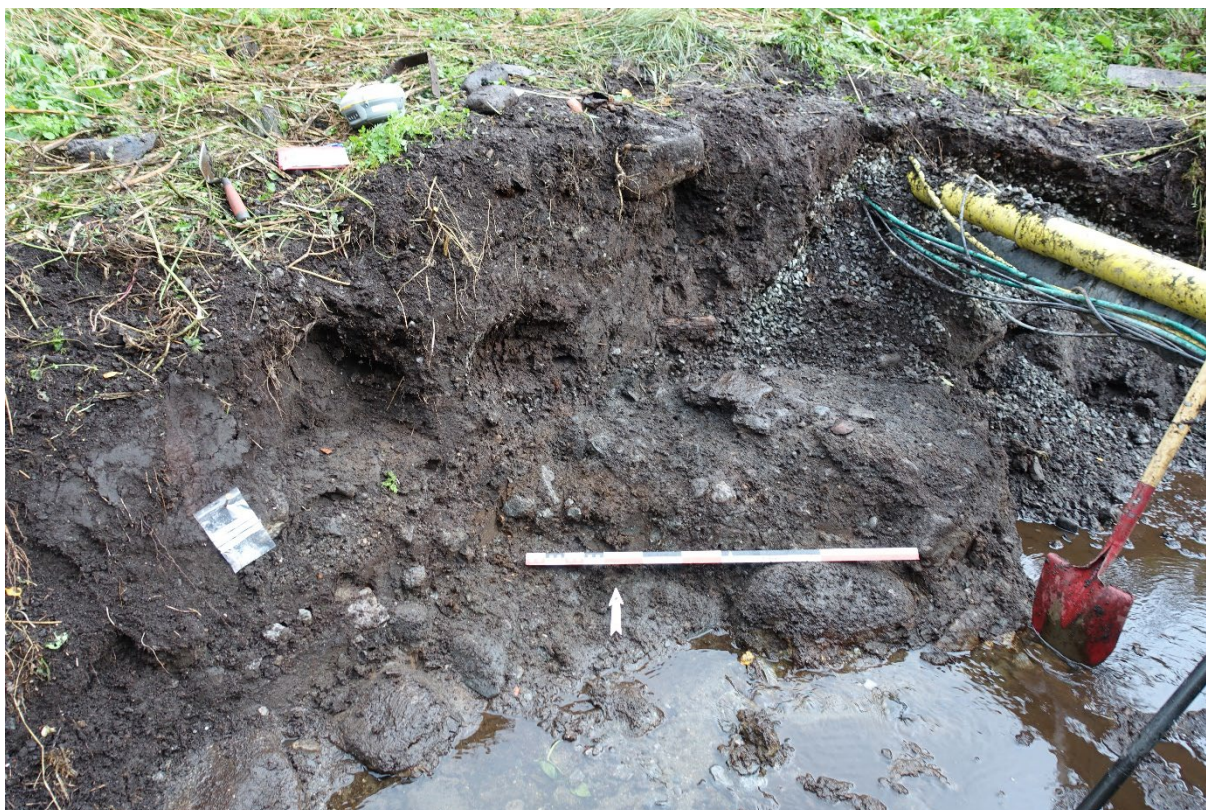
Figur 9 Profil C5067 mot nord, med rørgate og påført gruslag rundt rørene.
