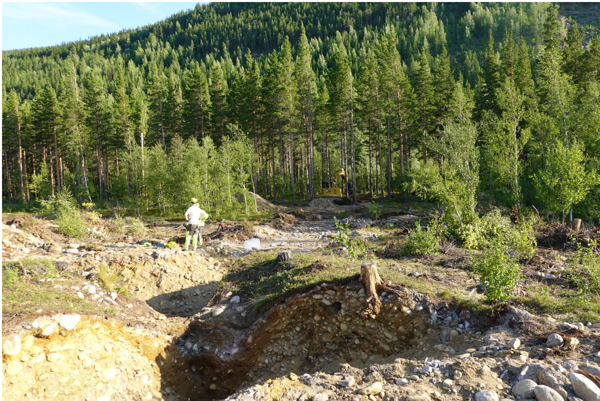
Figur 5: Prosjektet vart avslutta på ein godvêrsdag. Jørn og Johan sjekkar at alt er ferdig stilt, Ein kan sjå gravmaskinførar Glenn i bakgrunnen der han fyller igjen gropene med maskin.
