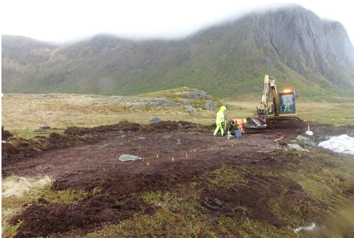
Figur 3 Avtorving av lokaliteten er nesten ferdigstilt
