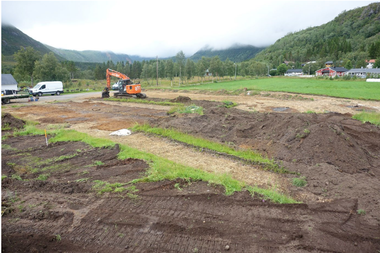
Figur 7: Lokaltetens flateavdekkingen pågår. Foto mot NV.
