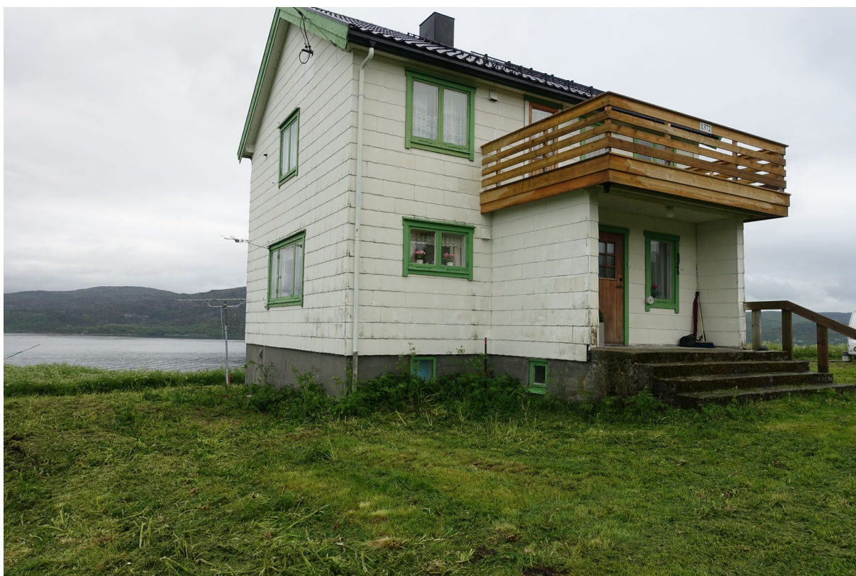
Figur 2: Våningshuset før drenering.
